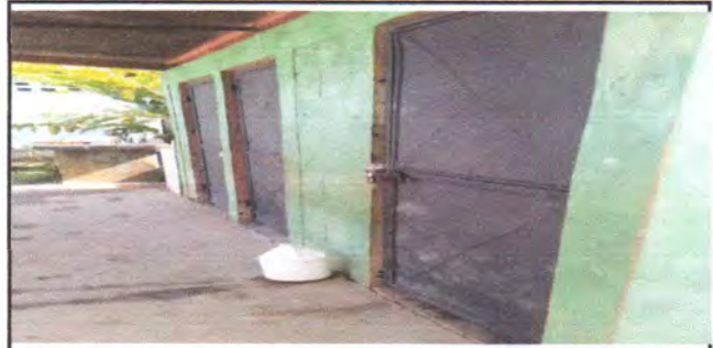
FOTO 2: Mantenimiento a estructura (lijado, cambio de tubo , cepillado, sujeciones, aplicación de pintura) a puertas servicios sanitarios
