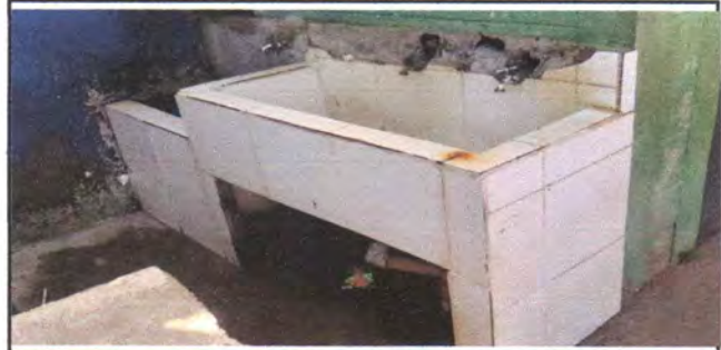
FOTO 4: Sustrucción de Azulejo para pila en Baños
