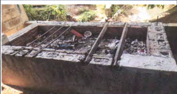
FOTO 9: Sustrucción de estufa rural (completa) incluye chimenea y plancha de metal EN COCINA
