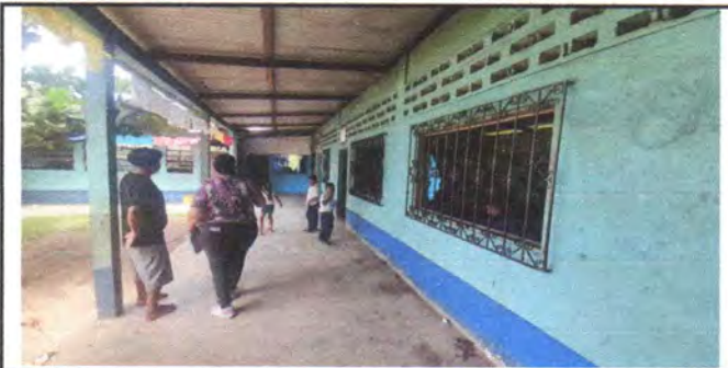
FOTO 16: Pintura en muros exteriores e interiores AULAS
