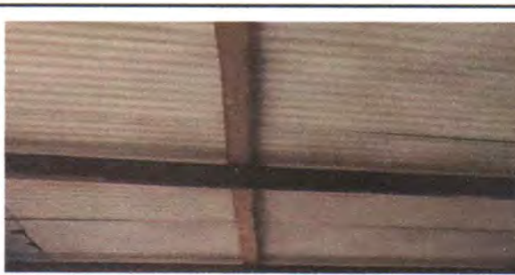
FOTO 12: Sustrucción de estructura de soporte de madera, por metal
