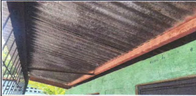
FOTO 1: Sustrucción de lámina, por lámina troquelada aluzinc calibre 26 EN BAÑOS y mantenimiento a estructura de soporte de metal
