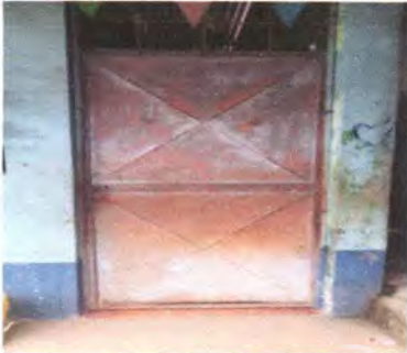
FOTO 13: Fabricación e instalación de metal en MODULOS
