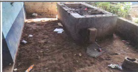
FOTO 7: Sustrucción de piso de tierra por piso de torta de concreto EN COCINA
