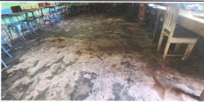
FOTO 15: Reparación de piso de cemento líquido
