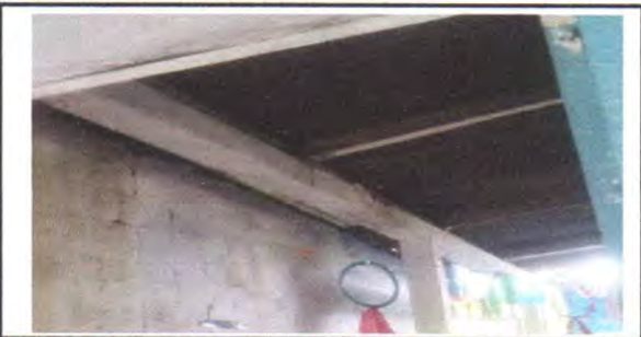
FOTO 11: Sustrucción de lámina, por lámina troquelada aluzinc calibre 26 Y Sustrucción de estructura de soporte de madera, por metal EN AULAS
