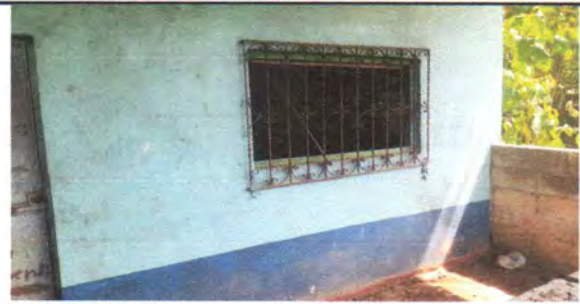
FOTO 6: Mantenimiento a balcones de metal
