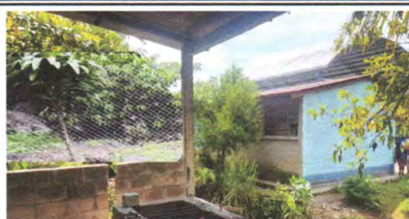
FOTO 8: Reparación de tubo hg y malla galvanizada
