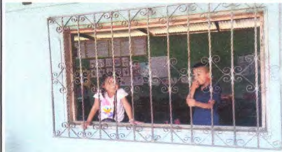
FOTO 14: Mantenimiento a balcones de metal EN AULAS
