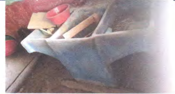
FOTO 10: Sustrucción de pila de cemento de dos lavadero EN COCINA
